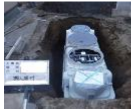
合併浄化槽設置
